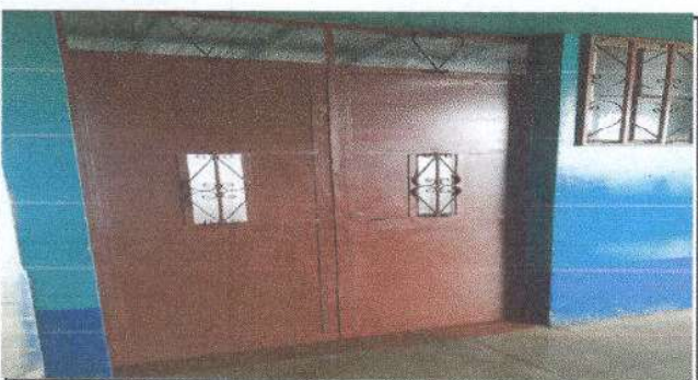
Foto 5: Cambio de puertas de las aulas
