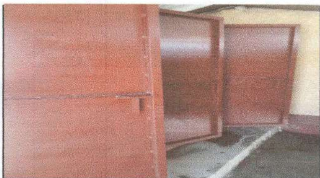
Foto 3: Cambio de puertas de baños
