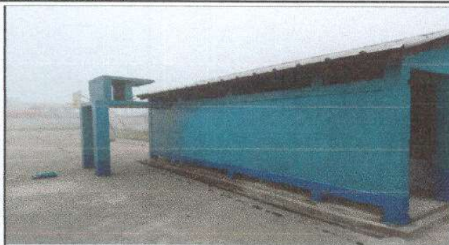
Foto1: Pintado del módulo de baños de varones
