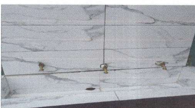
Foto 6: Colocación de azulejos en los lavamanos
